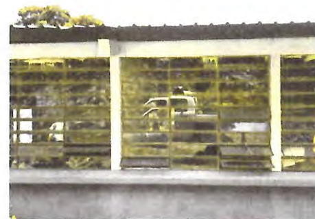
Foto 4: Sustitución de ventanas; sistema de apertura: Corredizas, Perfiles color blanco estandar, Material del marco: PVC Material de la ventana: Vidrio, sellado perimetral.
