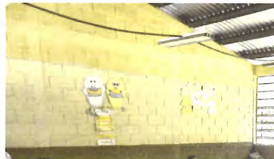
Foto 6: Reparación de repello y cernido en muro de mampostería con aplicacion de acabado uniforme
