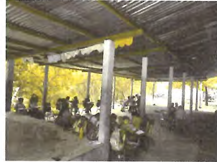
Foto 2: Sustitución de estructura metálica para soporte de cubierta de lámina incluyendo perfiles para vigas, travesaños, sujeta con tornillería; corte, soldadura y anclaje de la estructura portante.
