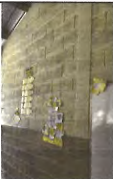
Foto 5: Preparación de la superficie y aplicación de pintura a dos manos, en paredes interiores y del establecimiento.
